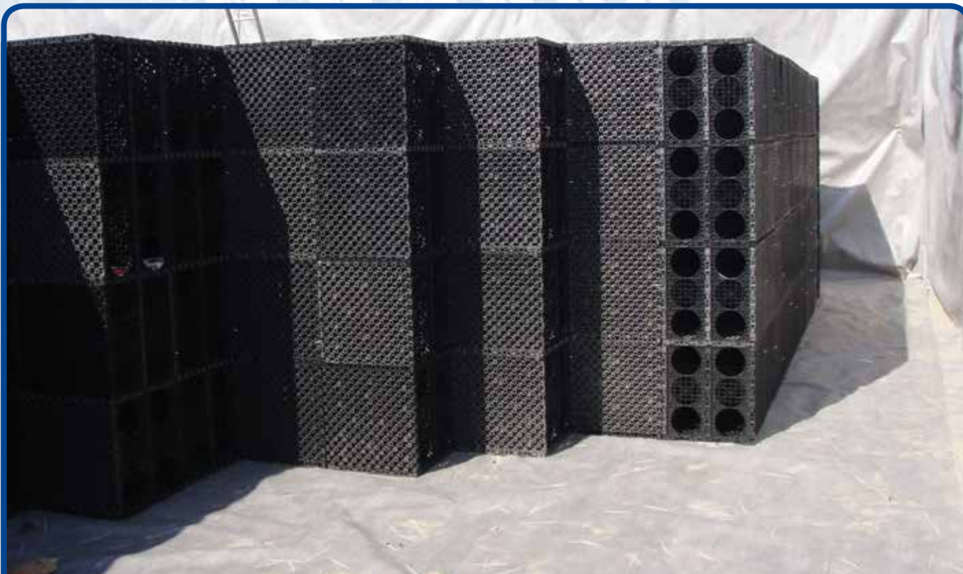
Infiltrationsmagasin 400 m 3 , kvadrupelmoduler
